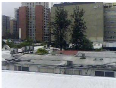
b) Techos desde la ventana de la UCSH
